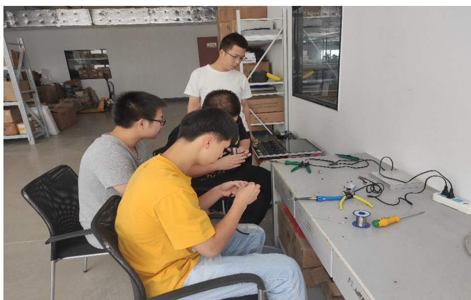
图 6-9 三系统配线、学习现场
